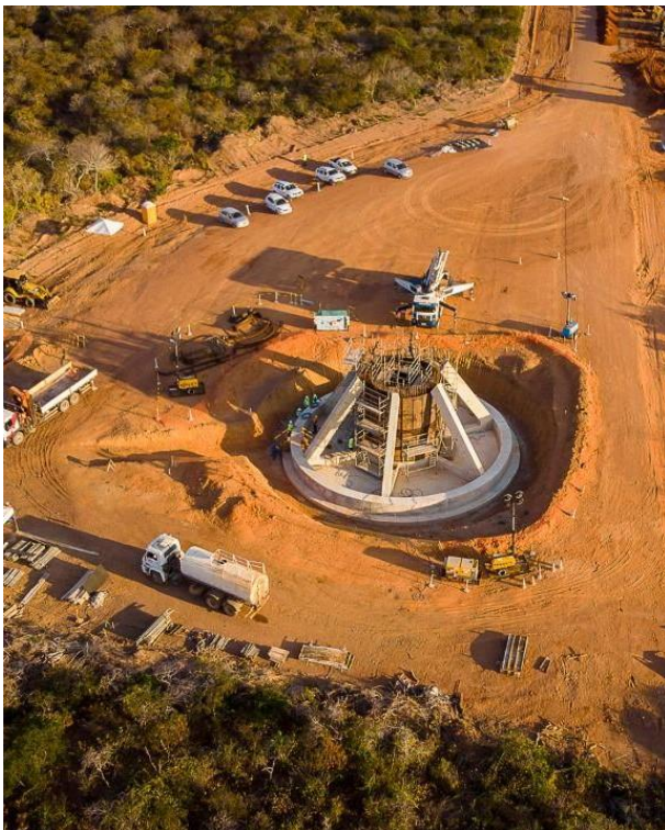
Fondation qui supportera une des 83 turbines de VSM
