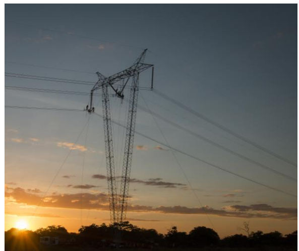
Une des 112 tours de la nouvelle ligne de transport de Voltalia
