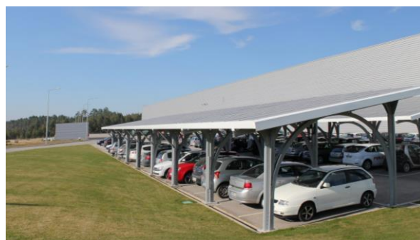
Ombrières solaires du parking des bureaux de Voltaia au Portugal
