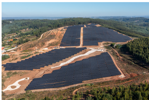
Antuzede (Garrido Complex), Portugal - 11.4 MW
