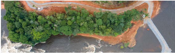
Centrale Oiapoque, Brésil
