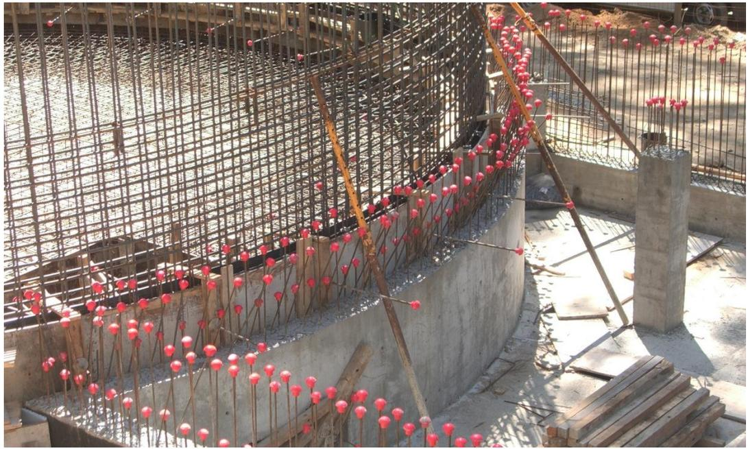
FIGURE 3 : ACIER D'ARMATURE SAILLANT AVEC CAPUCHONS DE PROTECTION DES BORDS.
