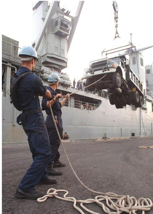
FIGURE 12: TRAVAILLEURS UTILISANT DES CORDONS DE BRASSAGE POUR GUIDER LA CHARGE LORS D'UNE OPERATION DE LEVAGE
