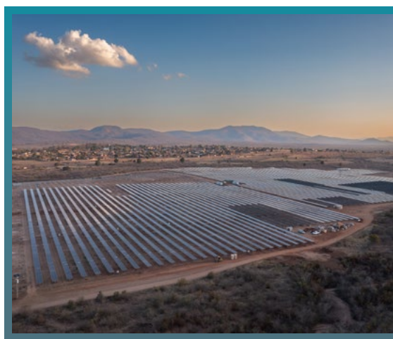
Centrale de Bolobedu en Afrique du Sud dont la production annuelle devrait permettre d'éviter l'émission de plus de 237 000 tonnes d'émissions de CO 2
