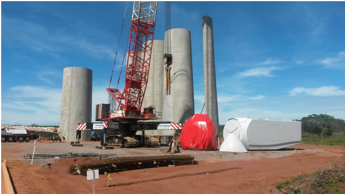
1 ère nacelle arrivée sur le site d'Areia Branca
