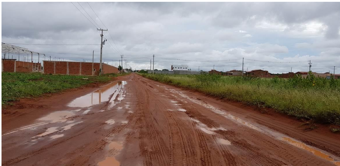
Figura 85: Ruas sem calçamento e sistema de drenagem. Fonte: Biotec, 2020.
