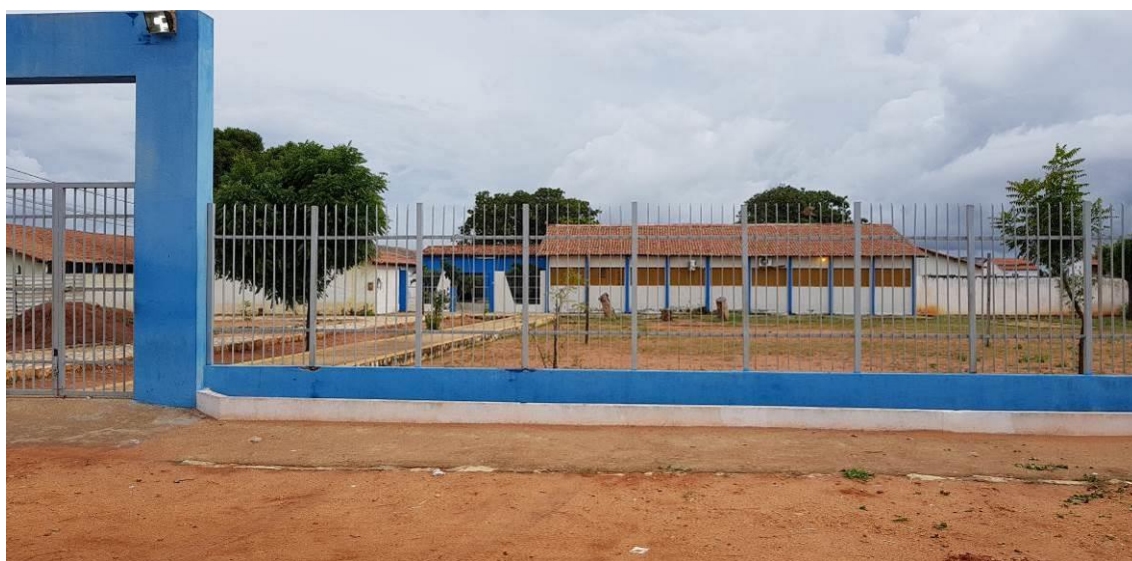
Figura 80: Escola localizada no centro do município. Fonte: Biotec, 2020.
