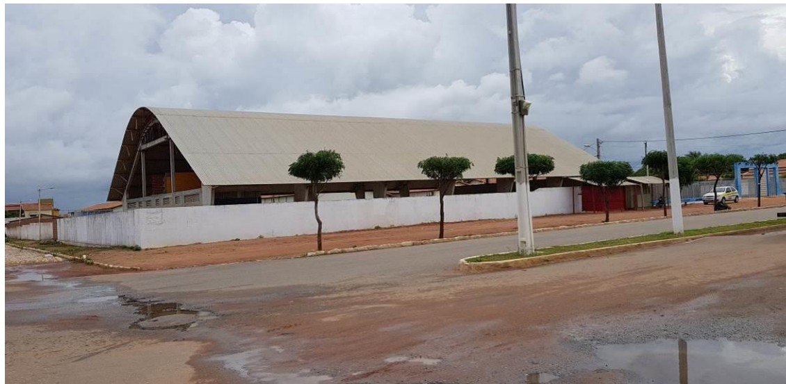
Figura 86: Ruas com acúmulo de água pluvial. Fonte: Pesquisa de campo.
