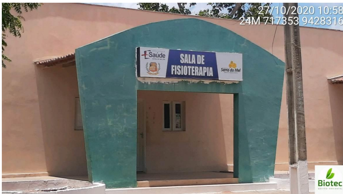
Figura 77: Centro de Especialidade Médica. Fonte: Biotec, 2020.
