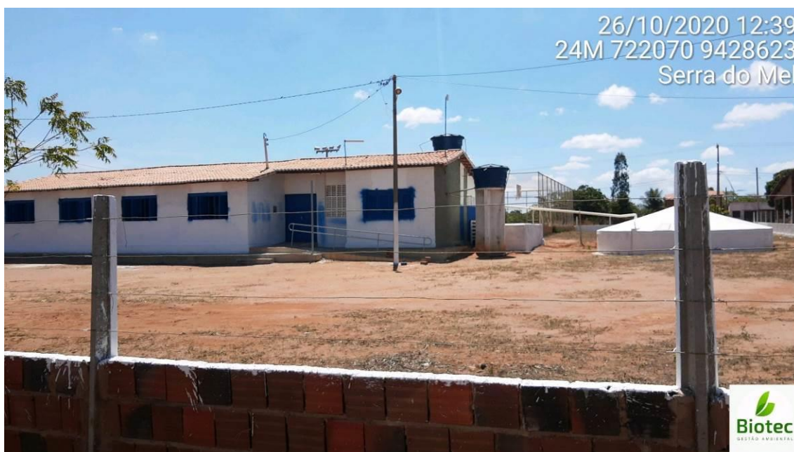
Figura 100: Escola localizada na Vila Pernambuco. Fonte: Biotec, 2020.
