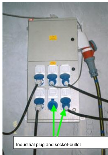
FIGURA 3: PADRÃO INDUSTRIAL PARA CABOS, PLUGUES E TOMADAS
