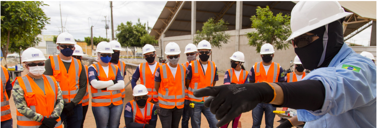
Os participantes do curso de formação de técnicos em segurança do trabalho estão sendo capacitados para atuar em empresas de construção civil. A foto mostra o momento de uma aula prática em uma obra de construção civil. Fonte: CVSS, São Paulo, SP.
