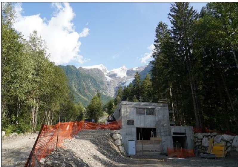
Les communes des Houches et de Chamonix ont contractualisé avec la société Voltaia pour la conception, la construction et l'exploitation d'une centrale hydro-électrique sur le torrent de Taconnaz qui sépare les deux communes. Photo mairie Chamonix
